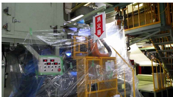
施工前の養生作業
